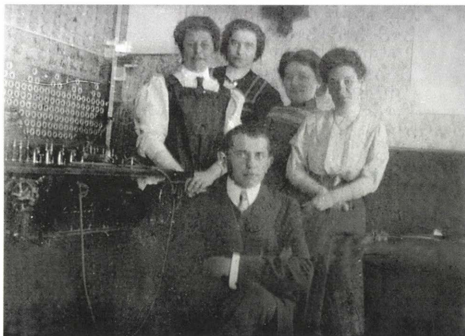
A soproni távbeszélőközpontban
