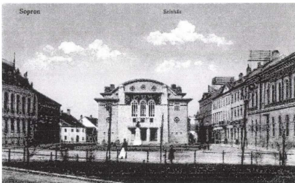
A Színház tér 2–4. szám alatti igazgatóság az épületeken a telefonhálózat tetőtartóival
