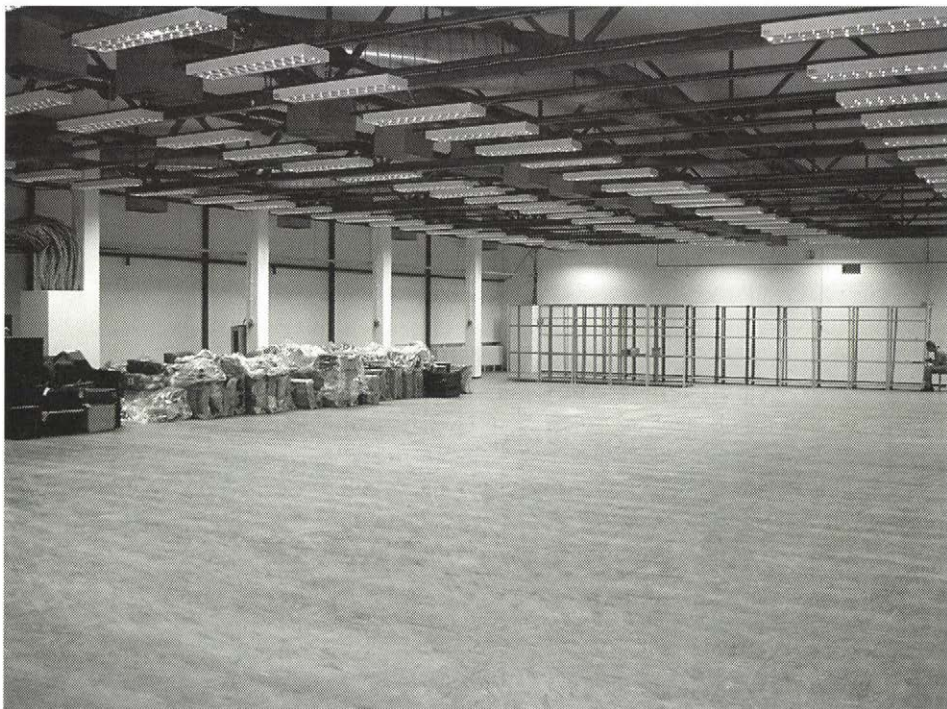
Miskolcon a már felújított gépterem a műtárgyak befogadására készen.
