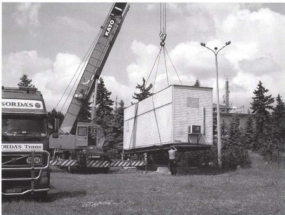
Az ARF 102 típusú konténerközpont lerakása Diósdon
