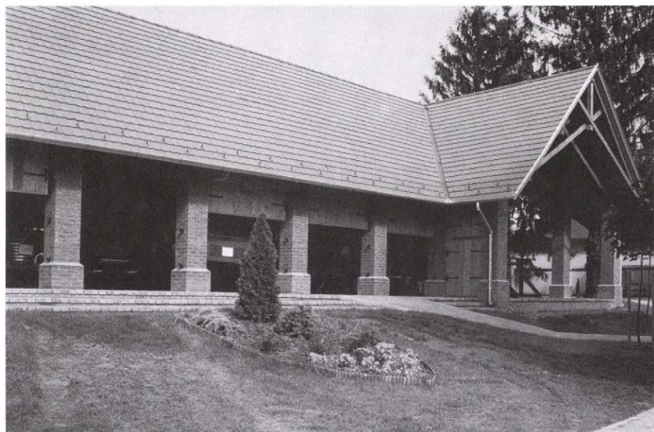
A postai járműveknek védelmet nyújtó új építésű kocsiszín
