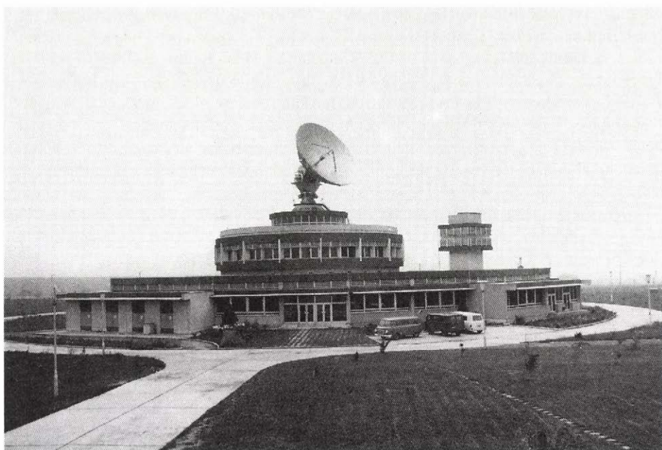
Az állomás épületegyüttese: előtérben a földszintes kiszolgáló épület, mögötte az antennát tartó műszaki épület
