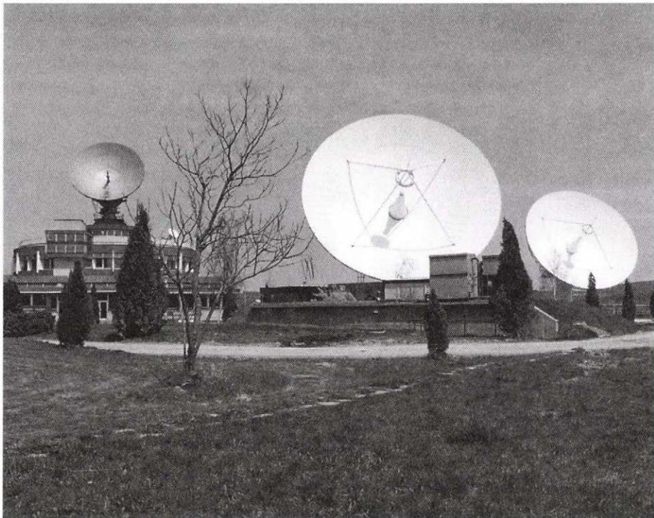
Látkép a hozzáépült Balaton-2A és Balaton-3A Intelsat STD-A típusú űrtávközlési földi állomással
