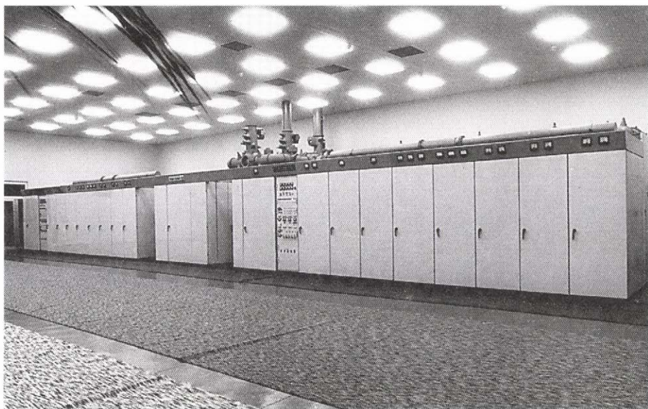
A 2×1000 kW-os középhullámú adóberendezés
