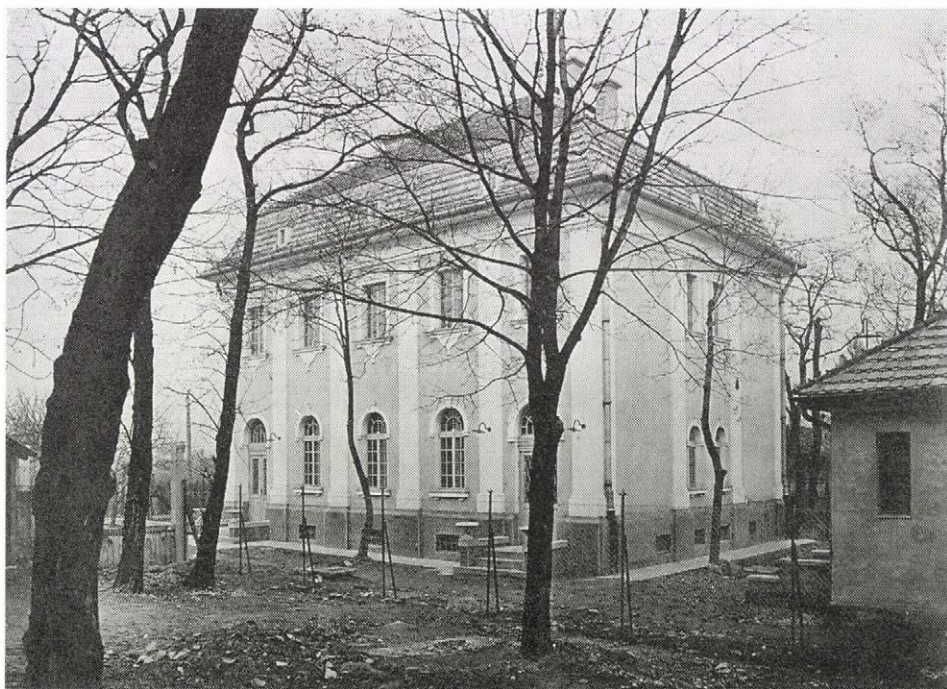
A svábhegyi távbeszélőközpont épülete
