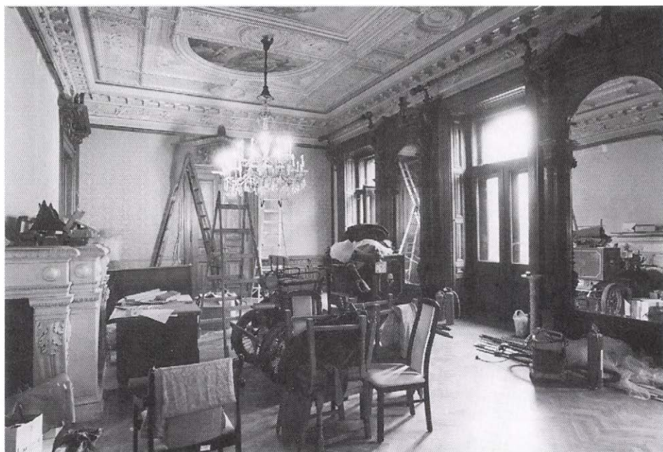
Az Andrassy úti múzeum a felújítási munkák közben
