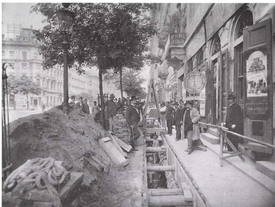
Klősz György: „A budapesti m. kir. távbeszélő hálózat földalatti kábeltömbjének beépítése.”
