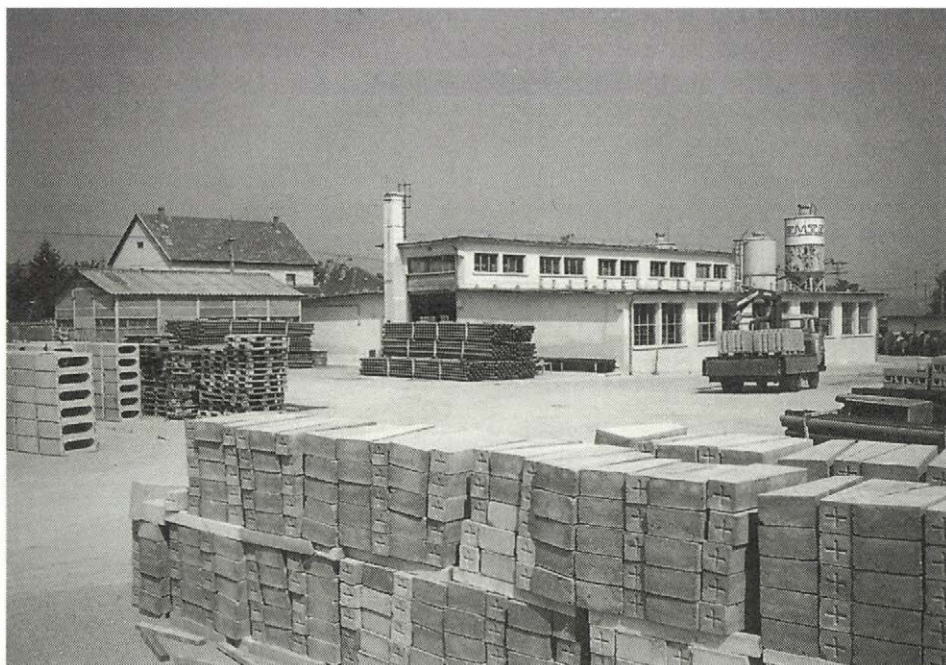
A Betonelemgyártó Üzem telephelye: Dunakeszi, Rév út 29.
