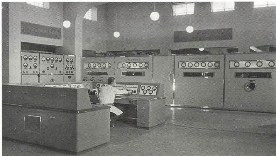
100 kW-os rövidhullámú adóberendezés, Diósd
