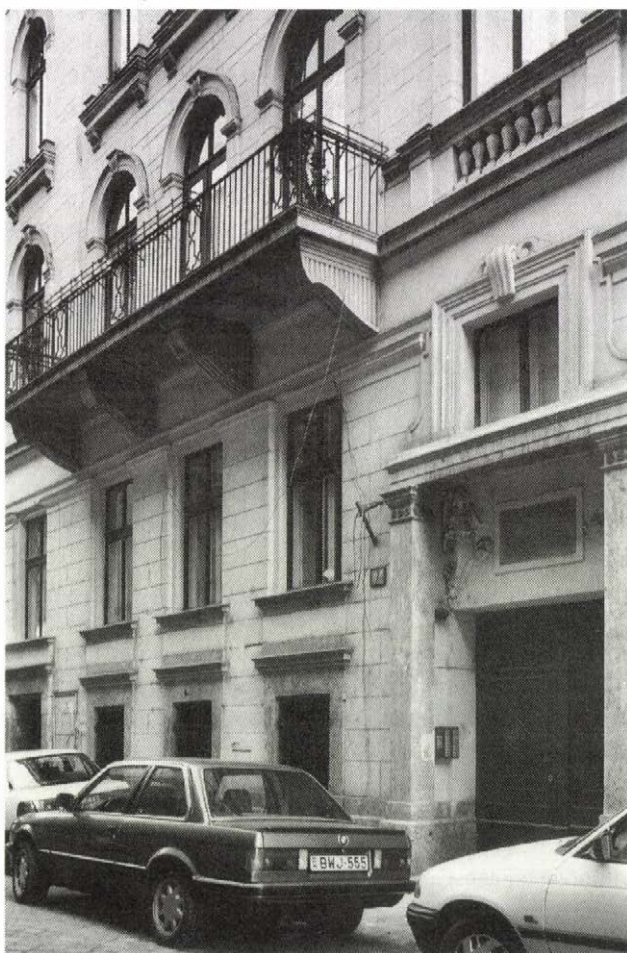
A Havas utcai lakóház
