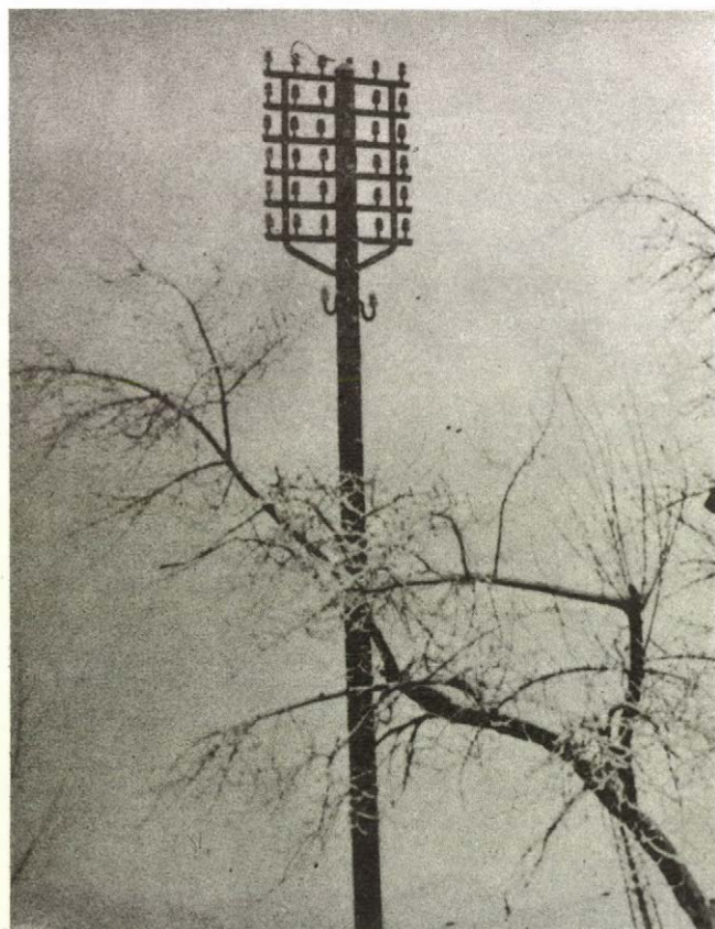
8. ábra: Egyes oszlop lírás szereléssel
