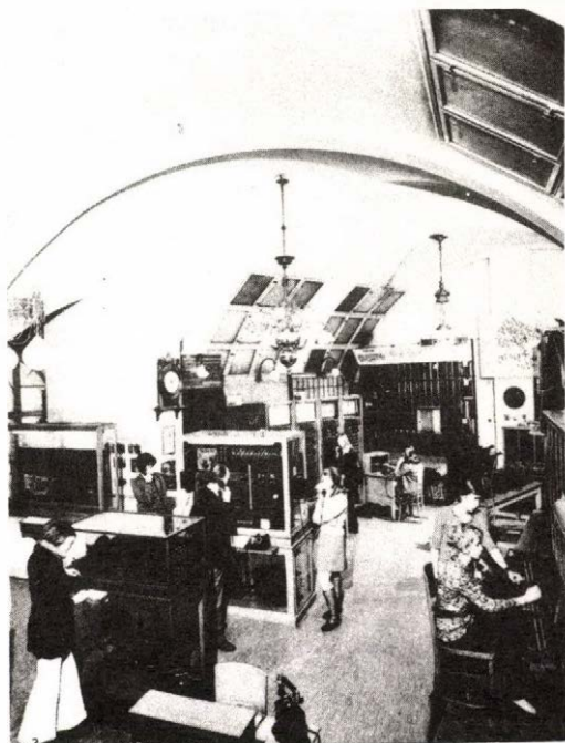
1. ábra: Látogatók a távbeszélő alközpontok csarnokában
