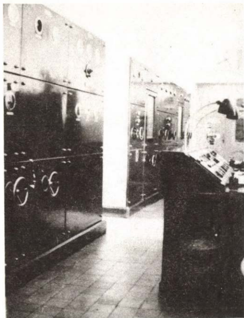
5. ábra: A 6,25 kW-os és a 30 kW-os fokozat az adóteremben
