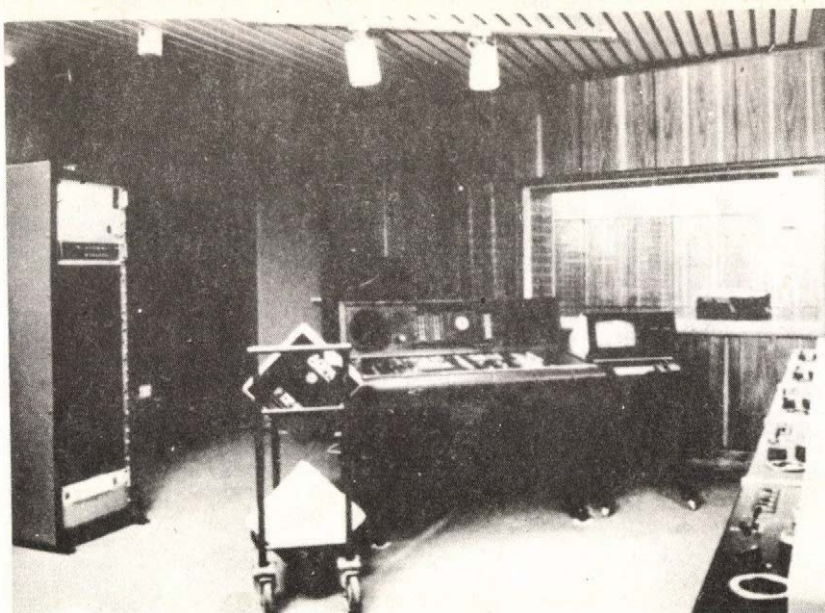
30. ábra. Műsorstúdió technikai helyisége BEAG AC 200 típusú mikroprocesszoros műsorlebegyőltő asztallal és STM 610 típusú magnókkal, 1987.
