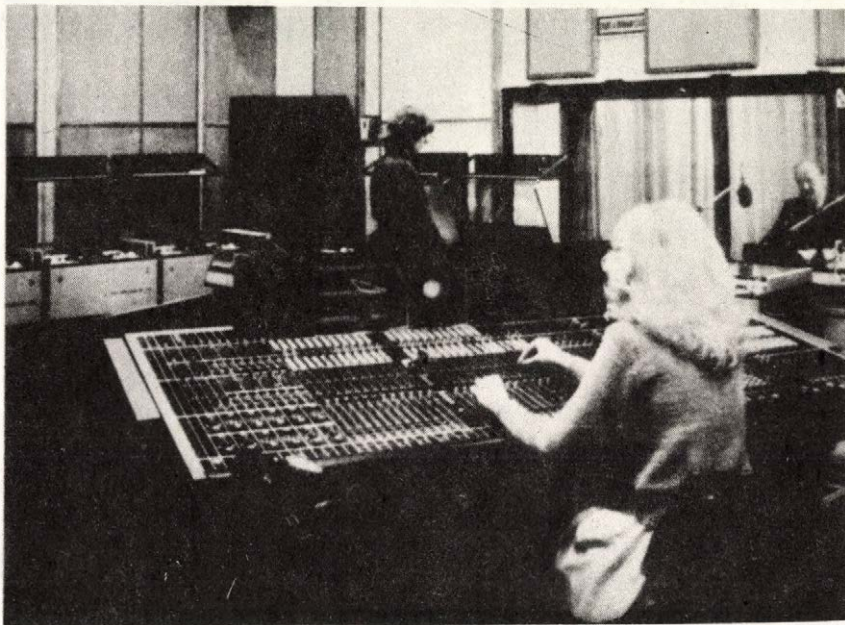
29. ábra. BEAG FIT-IC PKC 104 típusú keverőasztal és STM 210 típusú ML magnók a 2. stúdióban, 1985.
